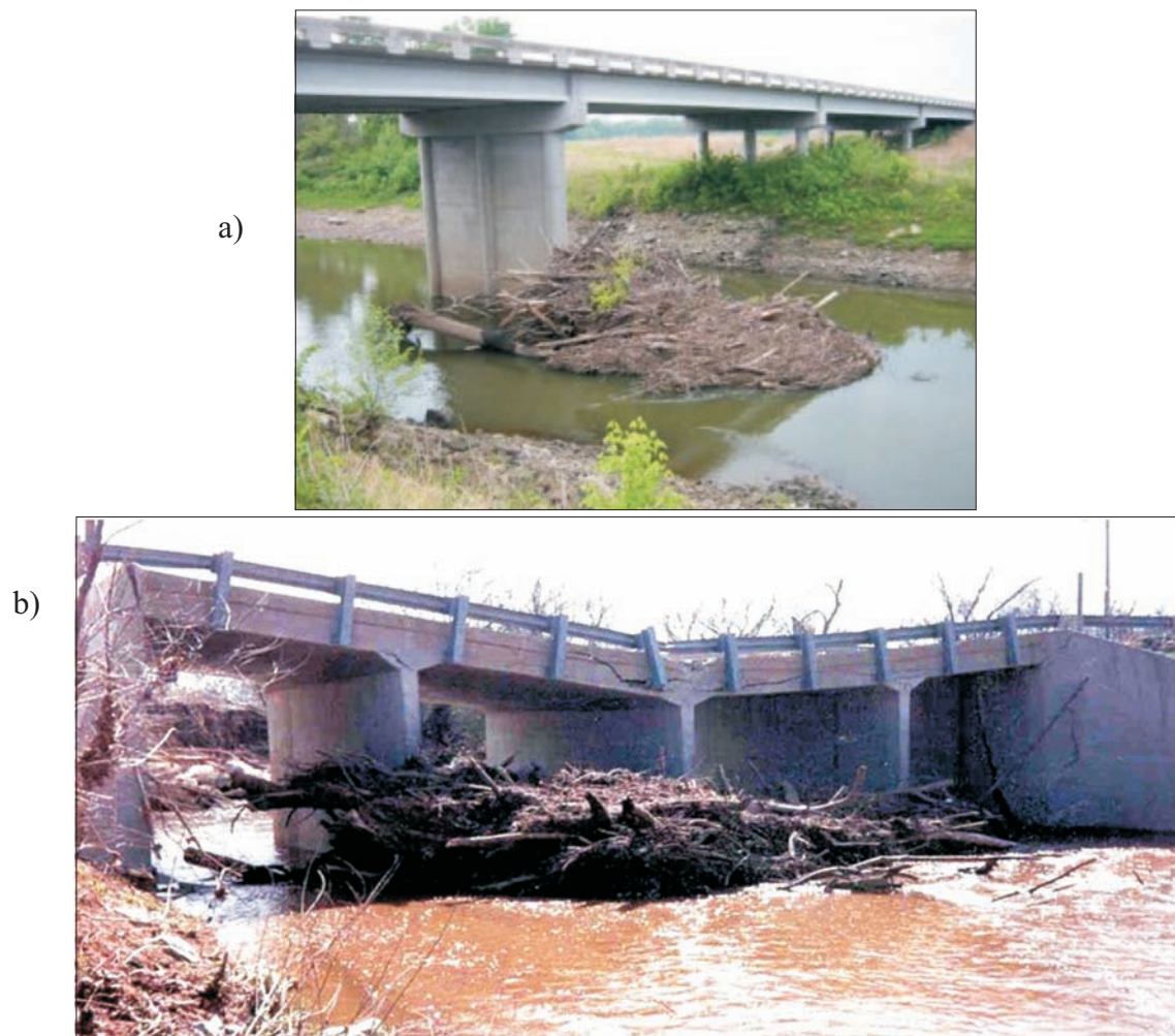
Rys. 3. Szczątki zatrzymane przez filar w czasie powodzi (a) i awaria mostu (b) wskutek wzrostu prędkości przepływu spowodowanego przez szczątki [15]
