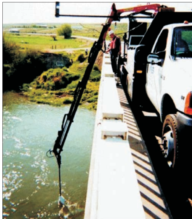
Rys. 40. Doprowadzani sonaru z mostu do miejsca pomiaru głębokości przegubowym wysięgnikiem zainstalowanym na samochodzie [Internet]
