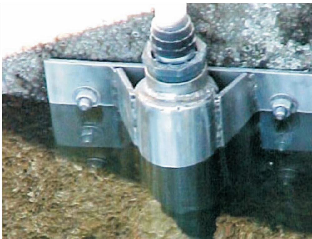
Rys. 4. Sposób połączenia stałego sonaru z filarem [8]
