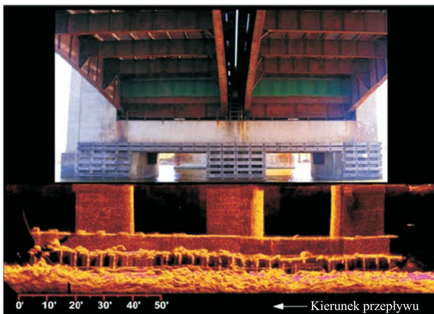
Rys. 15. Podwodny obraz sonarowy i zdjęcie nad powierzchnią wody łącznie prezentują dno rzeki oraz strukturę podwodną mostu (sonar skanujący) [8]
