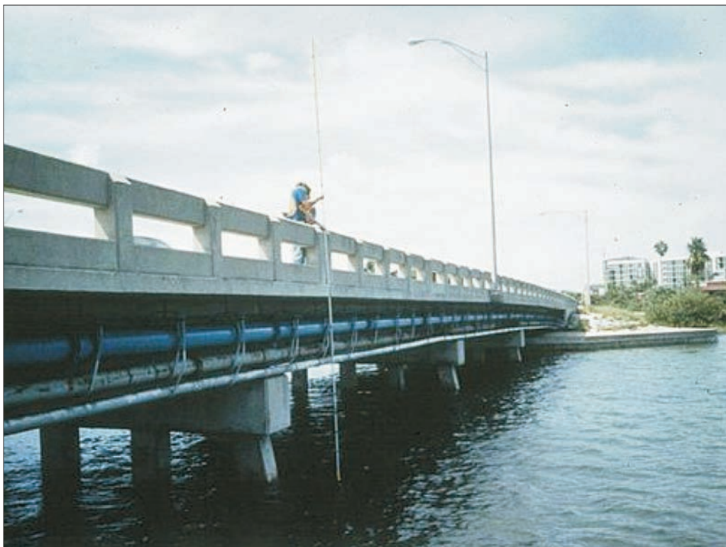
Rys. 1. Pomiar głębokości dna z pomostu przenośną fizyczną sondą tyczkową [13]
