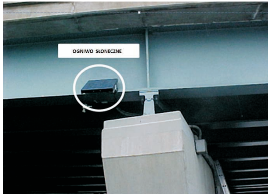
Rys. 16. Ogniwo słoneczne zainstalowane na pasie dolnym blachownicowego dźwigara głównego górnej konstrukcji mostu [8]
